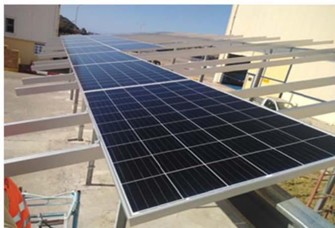
**Résistance :** La structure est composée de profilés, qui sont vissés ou boulonnés entre eux, ce qui confère à la structure une plus grande flexibilité, lorsque celle-ci est comparée à une structure en béton.
