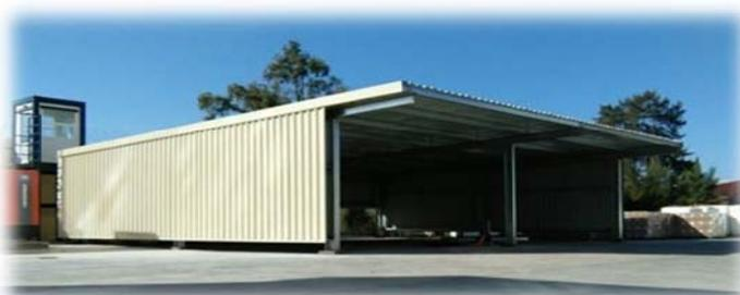
**Rapidité :** La construction en profilés laminés à froid est plus rapide que les méthodes traditionnelles de construction des hangars et des bâtiments.
